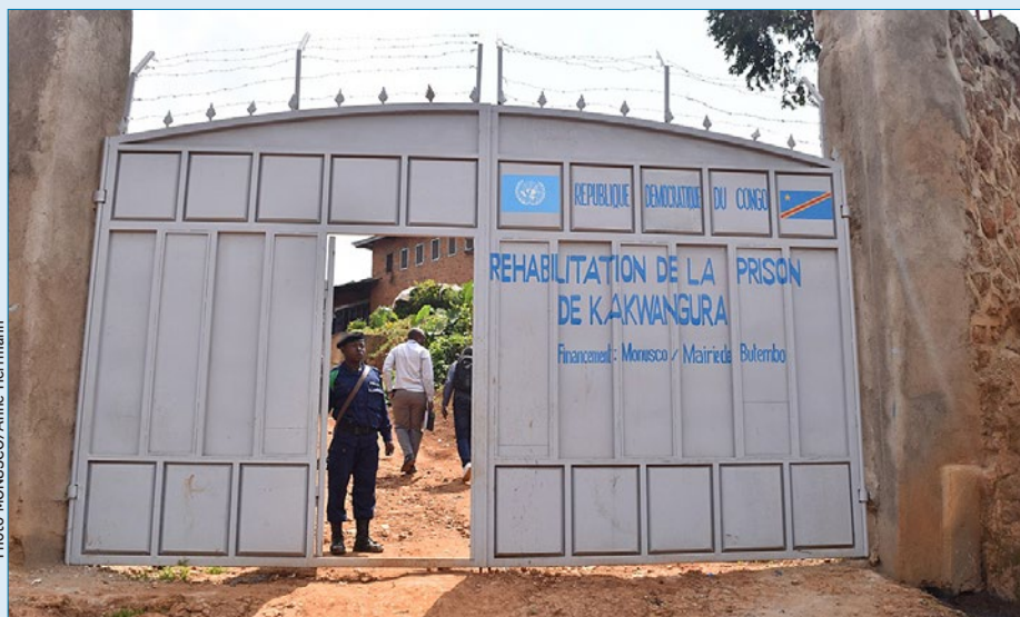
Vue de l'entrée de la prison centrale de Butembo après sa rénovation
