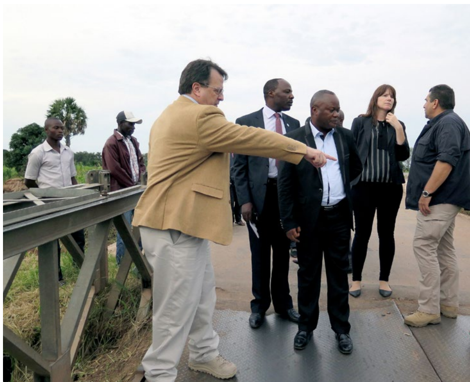
A Kalemie, M. David Gressly, accompagné du Vice-gouverneur de province, a inspecté le pont Kituku qui s'est écroulé suite aux pluies torrentielles, isolant plusieurs zones dont la base de la MONUSCO du reste de la ville
