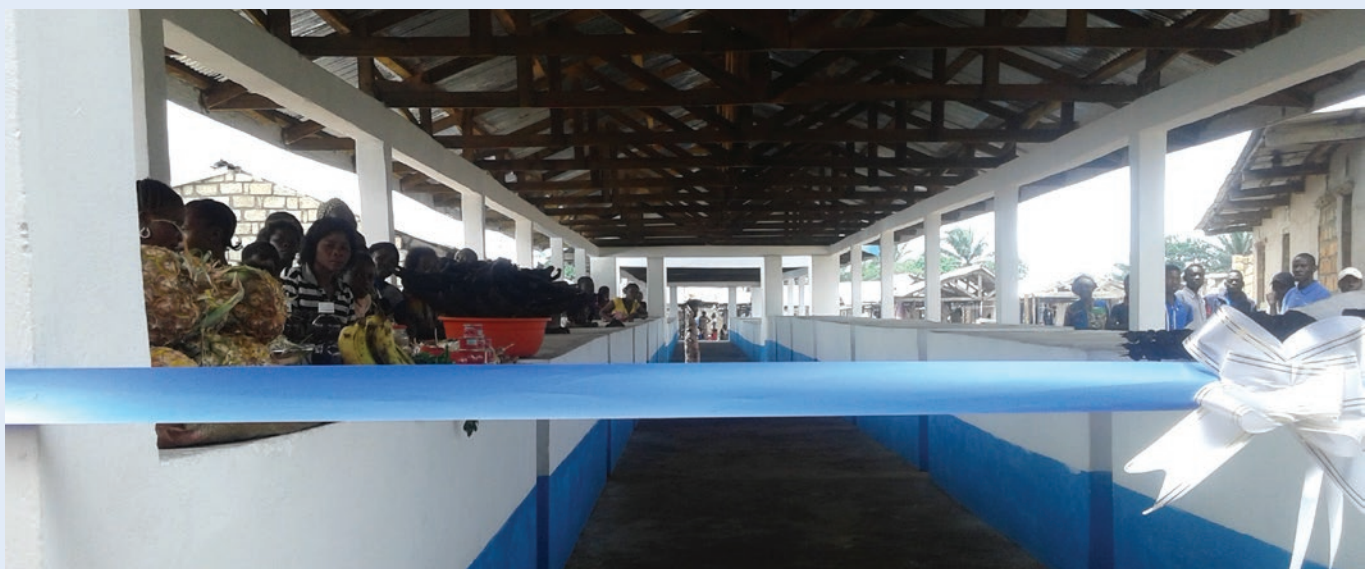
Vue panoramique du marché de Kamina construit par la MONUSCO
